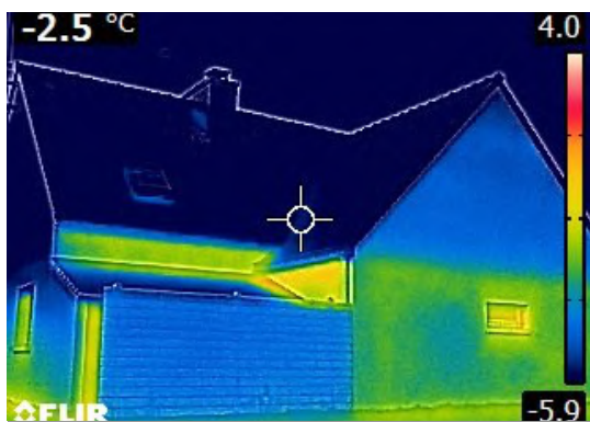
Cliché thermographique d'un logement sélectionné
