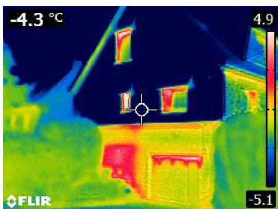
Cliché thermographique d'un logement sélectionné
